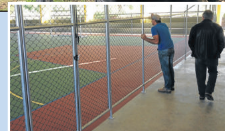
Quadra esportiva receberá última demão de pintura
