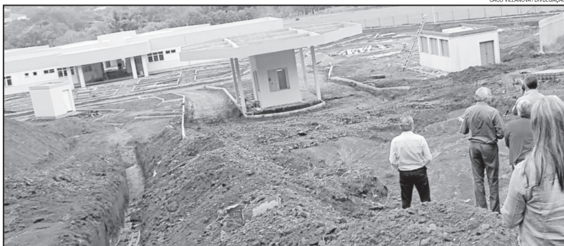
Obras da primeira etapa do campus de Lajeado estão 60% concluídas
