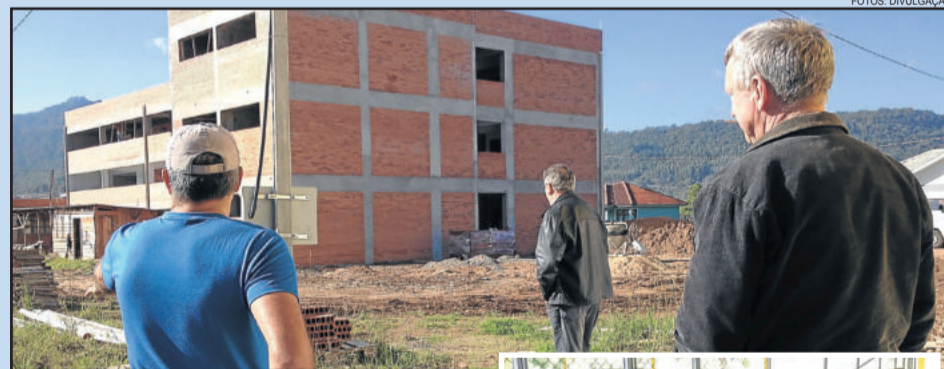
Prédio de três andares está na fase de pisos e acabamentos
