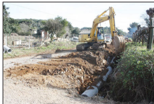
Rua das Videiras recebeu obras de canalização
