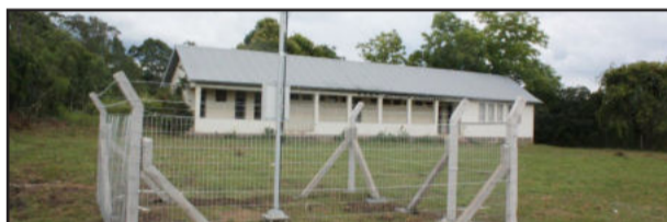
Estação Meteorológica em São Gotardo
