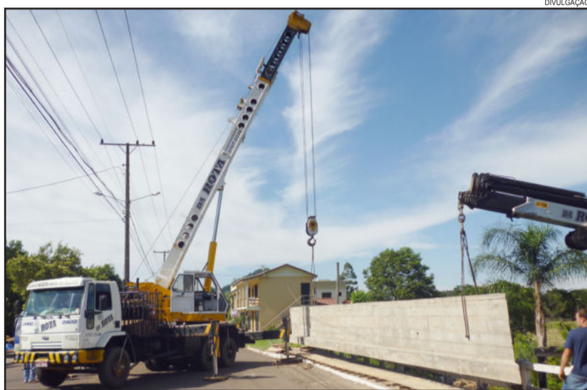
Ponte da Av. Henrique Uebel recebe melhorias na estrutura
