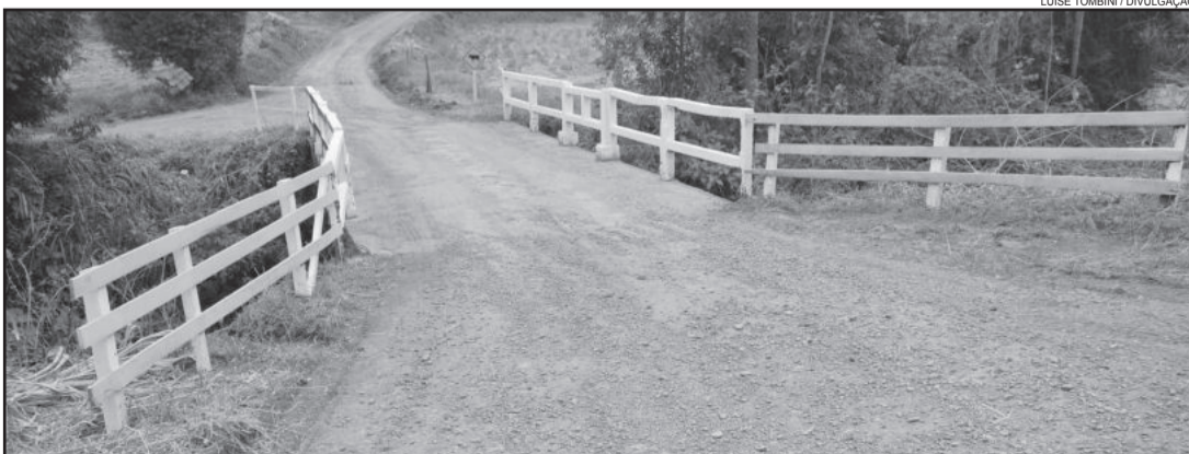
Na Linha Imhoff, ponte recebeu nova pintura nas guias de proteção
