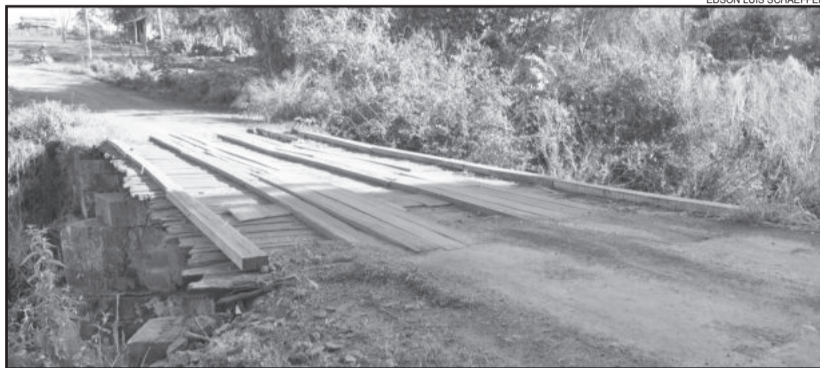
Convênio entre prefeituras permite reconstruir a ponte na divisa com Westfália
