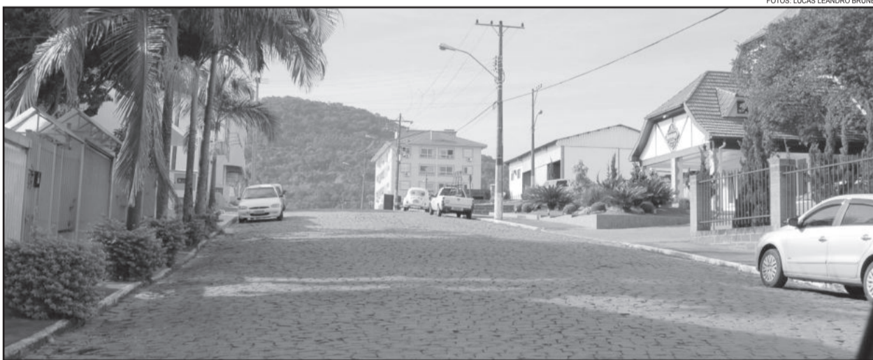
Rua 2 Norte receberá capa asfáltica
