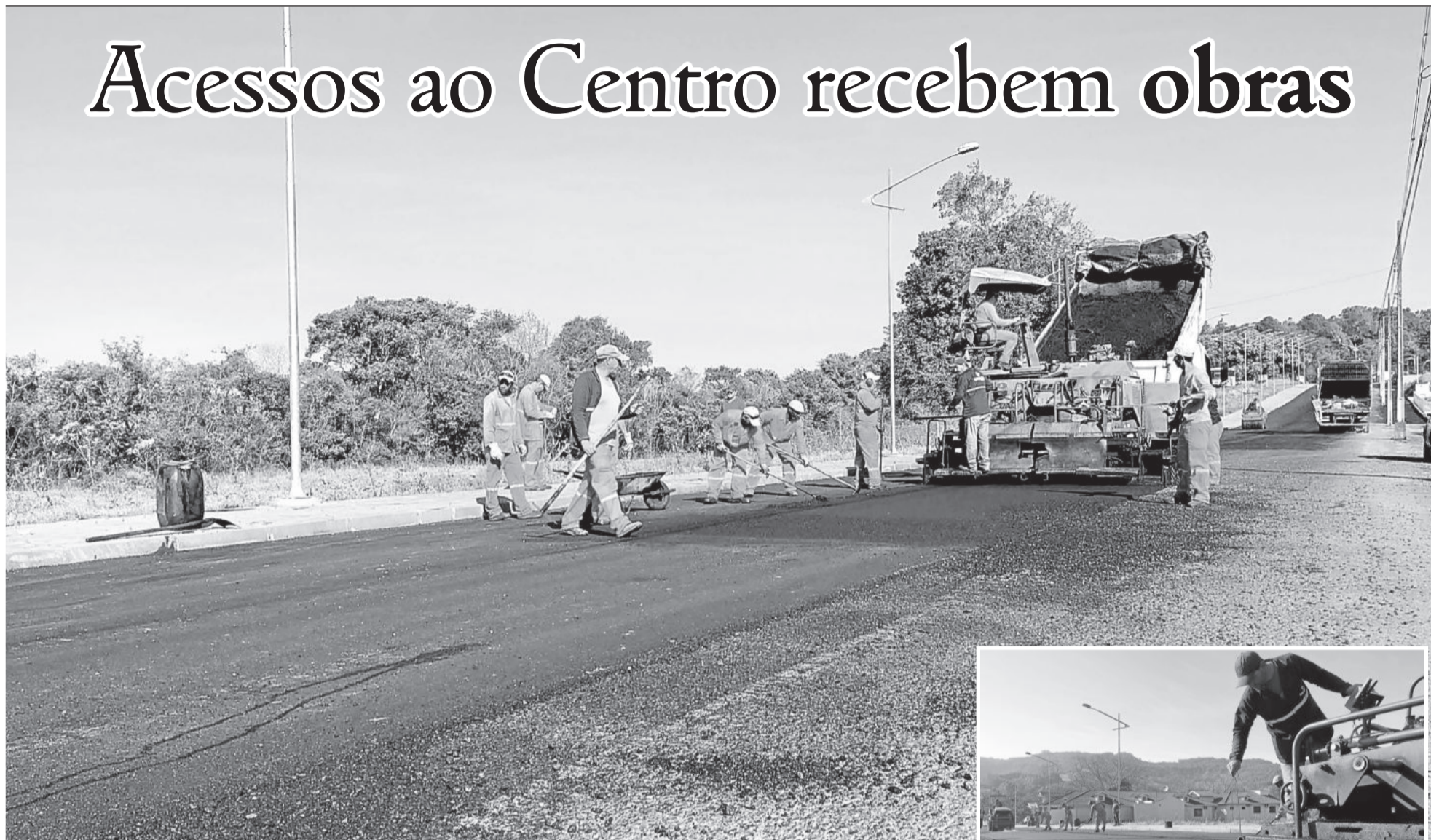
Acesso principal pelo trevo está sendo revitalizado
