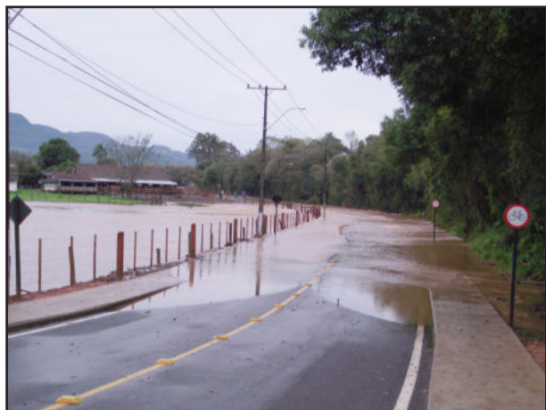
Estrada da Várzea, que liga os bairros Languiru e Teutônia, ficou interrompida por 18 horas
