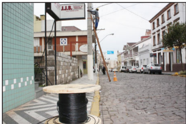
Instalação da fibra óptica
