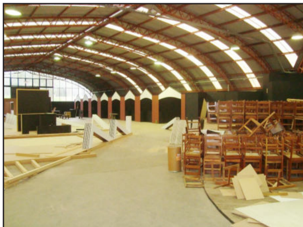
Área interna dos pavilhões
