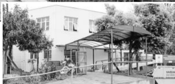
Postos Central (no alto) e São Francisco reformados
