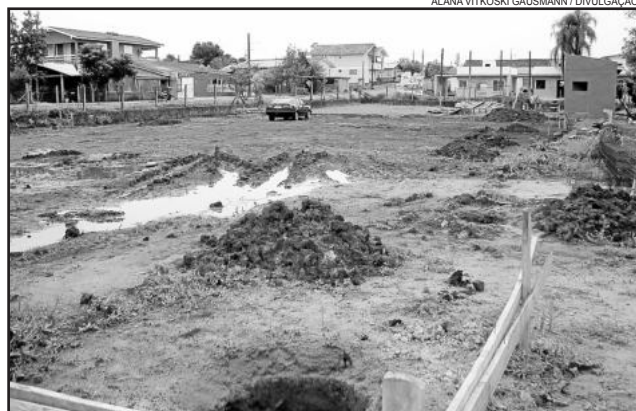
Quadra Poliesportiva está sendo construída no Bairro Alesgut
