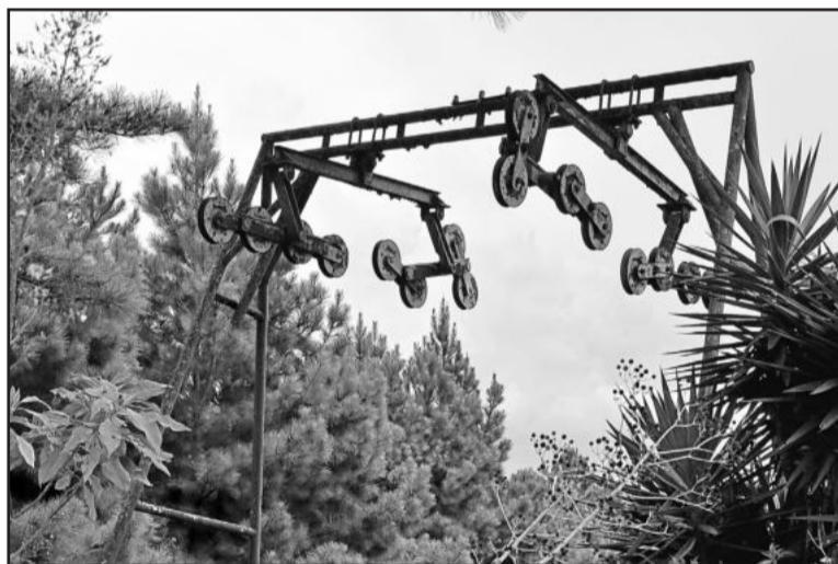
As roldanas do teleférico estão corroídas pela ferrugem
