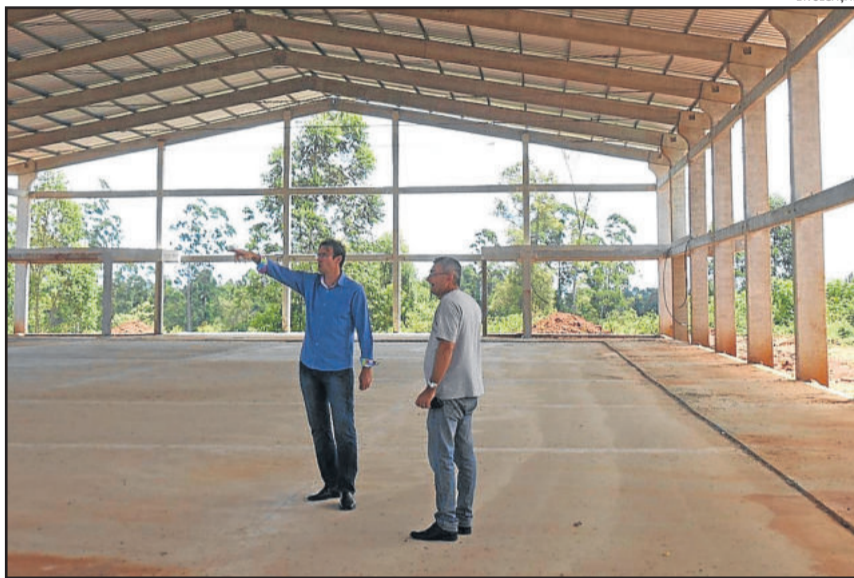
Biondo acompanhou obras do Ginásio da EMEF Teobaldo Closs
