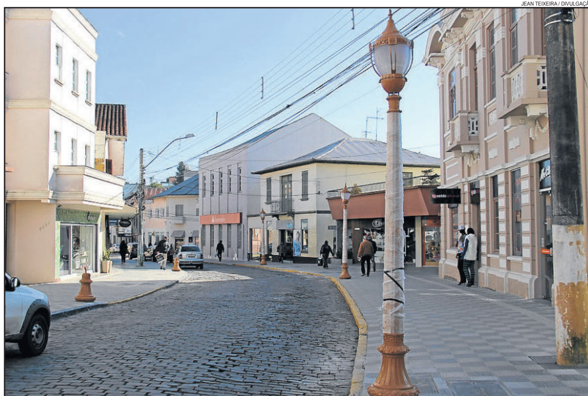
Novos postes foram instalados
