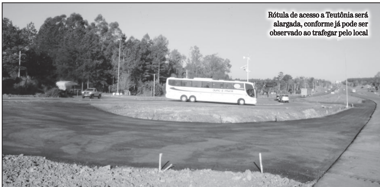
O trecho de dois quilômetros, onde está localizada a aldeia indígena, é o principal entrave, seguindo sem obras
