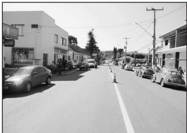
Ruas, como a 4 de Julho, receberam melhorias na sinalização
