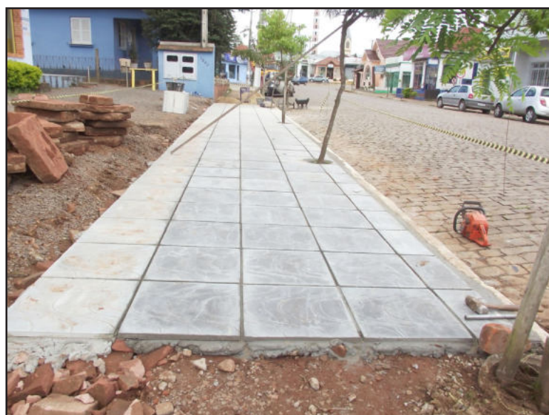
Com incentivo do Município, calçadas no Centro de Paverama são modernizadas
