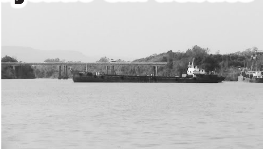
Ponte BR 386 sobre Rio Taquari entre Estrela e Lajeado
