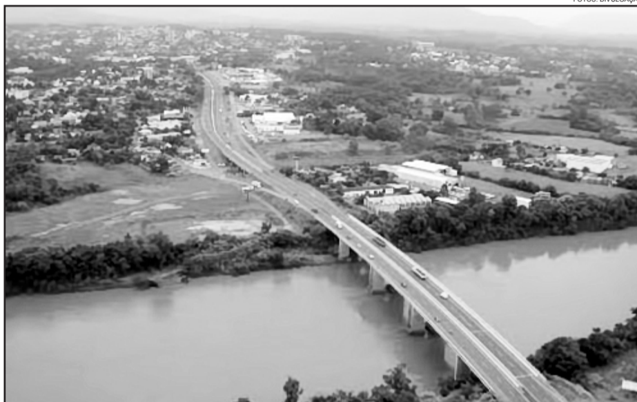
Ponte BR 386 sobre Rio Taquari entre Estrela e Lajeado
