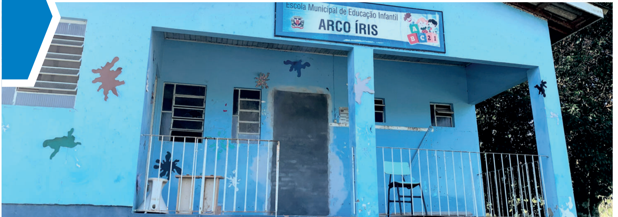
Antiga creche está sendo transformada em unidade de Saúde
