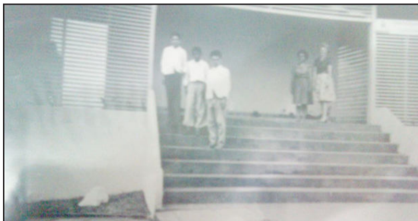
Prédio situado na Rua Tiradentes foi construído na década de 60, no antigo modelo das Brizoletas
