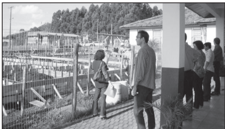
Construção de nova estrutura no CEMEF Leonel de Moura Brizola
