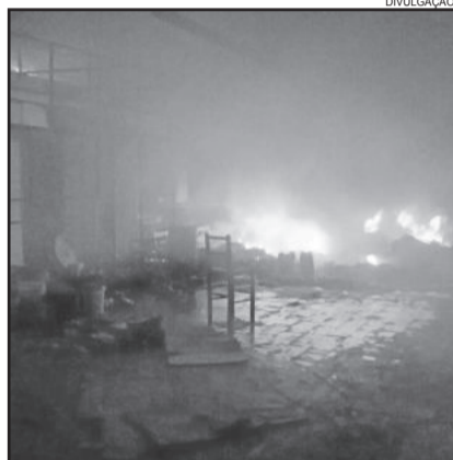
Parte do prédio foi consumido pelo fogo
