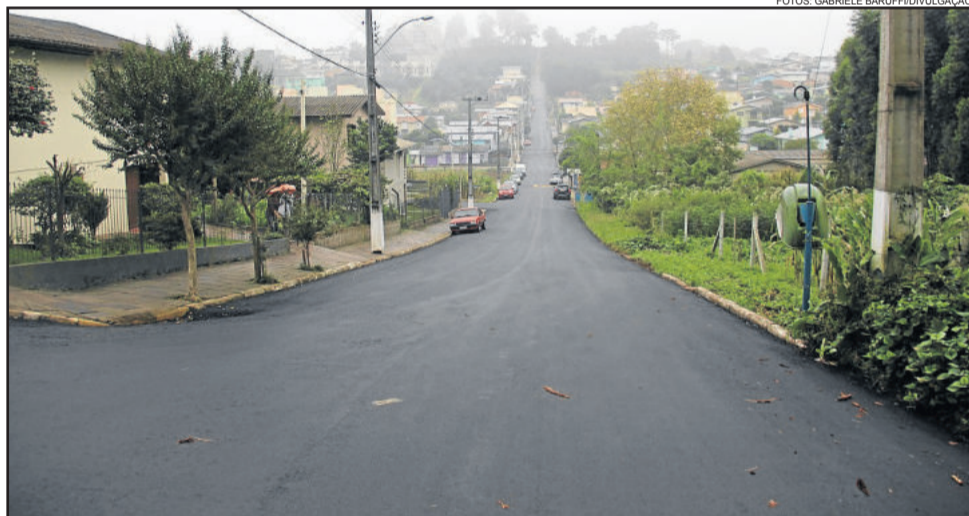
15 de novembro já está em fase final da obra
