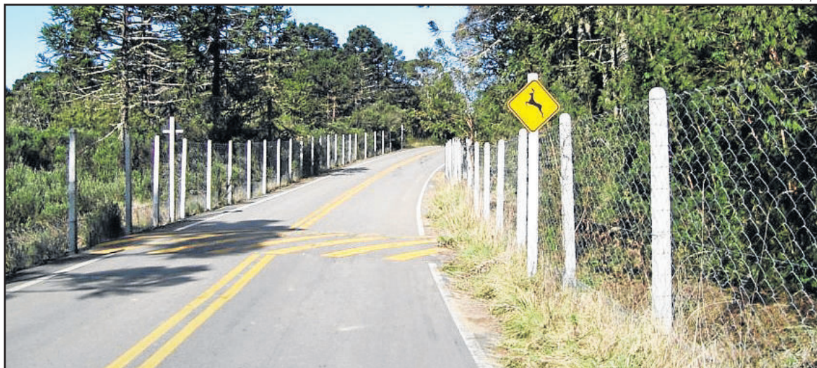
Exemplo de cerca utilizada para evitar que os animais passem pelas estradas
