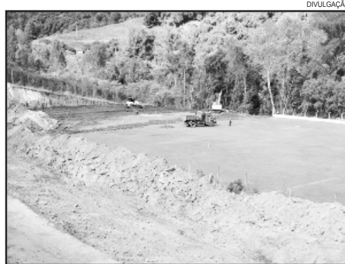
Obras no entorno do gramado tem previsão de término para setembro
