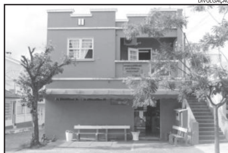
Prédio do CRAS
