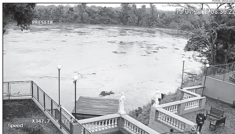
Escadarias em Estrela
