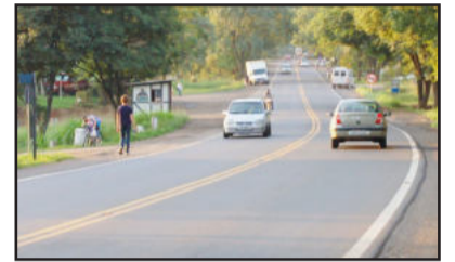
Via Láctea é uma rodovia perigosa
