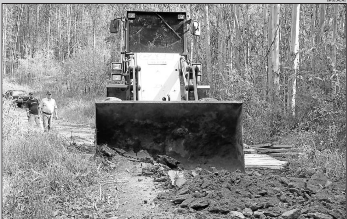
Recuperação da Ponte do Recanto Körner
