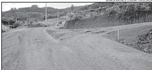
Trecho onde será realizado o asfaltamento
