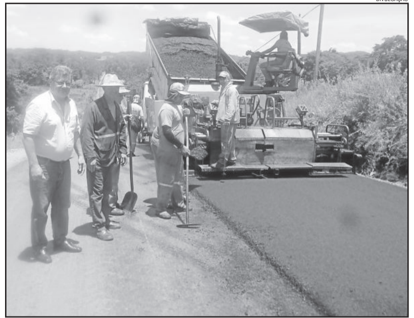
Marasca acompanhou fase final do asfaltamento
