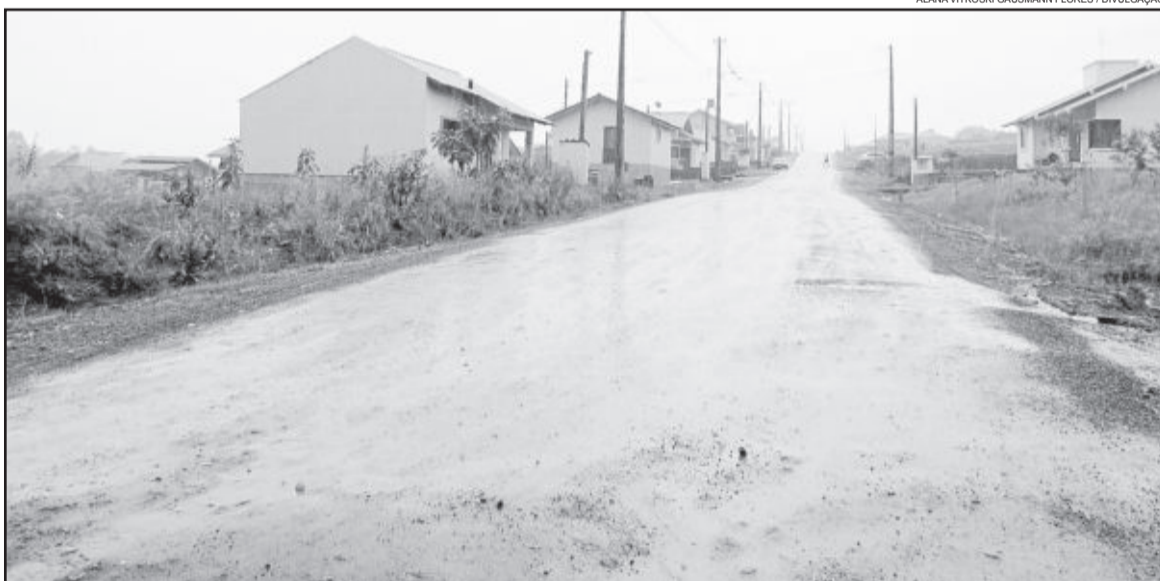
Pavimentação Rua Guilherme Sobrinho - entre Ernani Julio Sippel e Julio Stum
