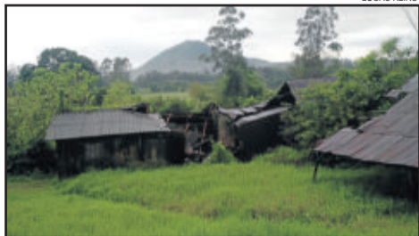
Casa atingida na estrada entre Boa Vista e Linha Frank
