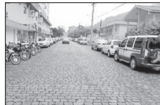
Caçamento Rua Fernando Ferrari - entre a Santos Dumont e a Frederico Lindemann
