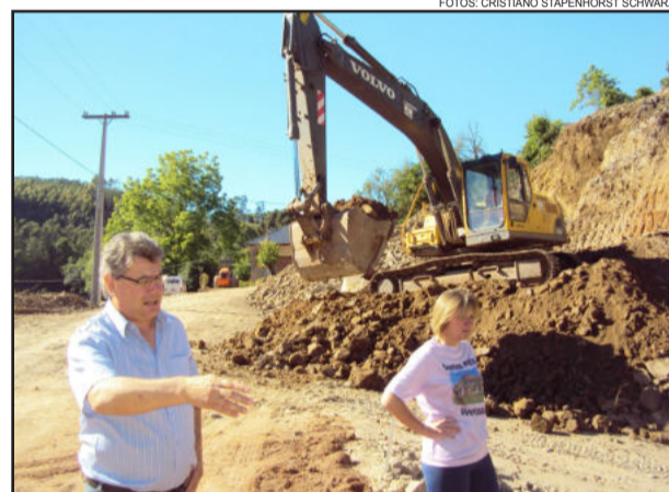
Marasca e Evante conferem andamento das obras em Westfália
