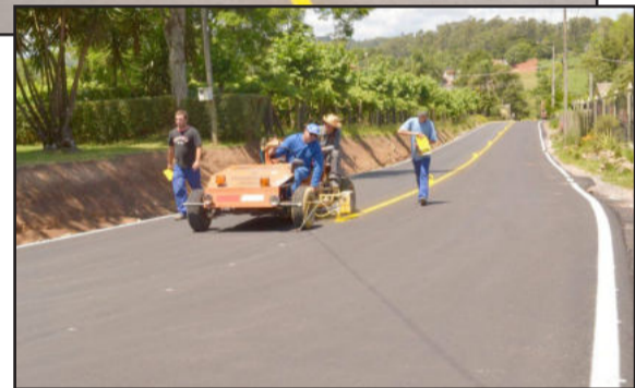
Asfalto recebe últimos detalhes
