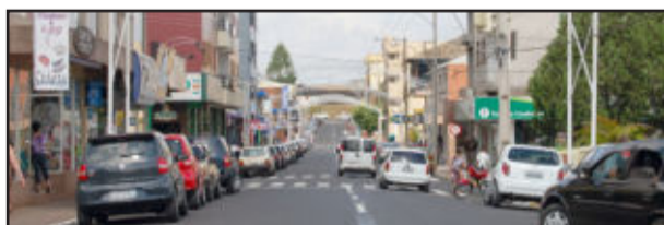
Capeamento da Rua Capitão Schneider
