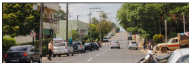
Capeamento de trecho da Rua Dom Pedro II
