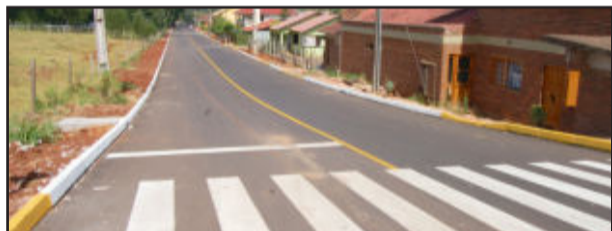
Rua Hatto Brönstrup está concluída
