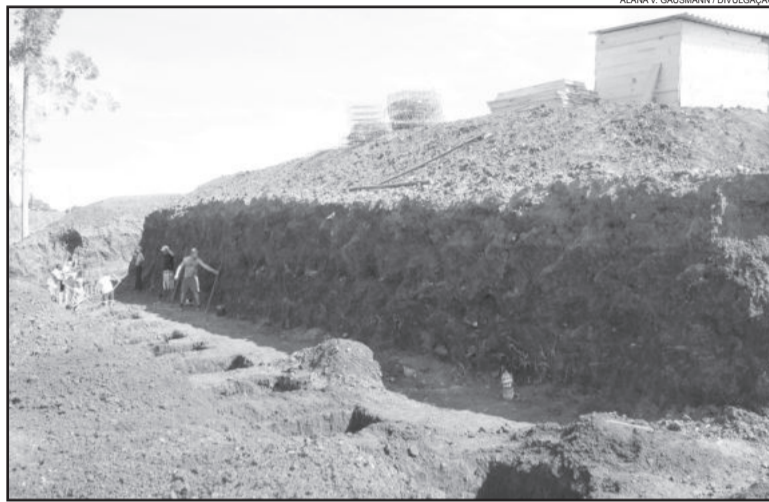
Construção de muro de contenção representa um investimento de R$ 129.669,50
