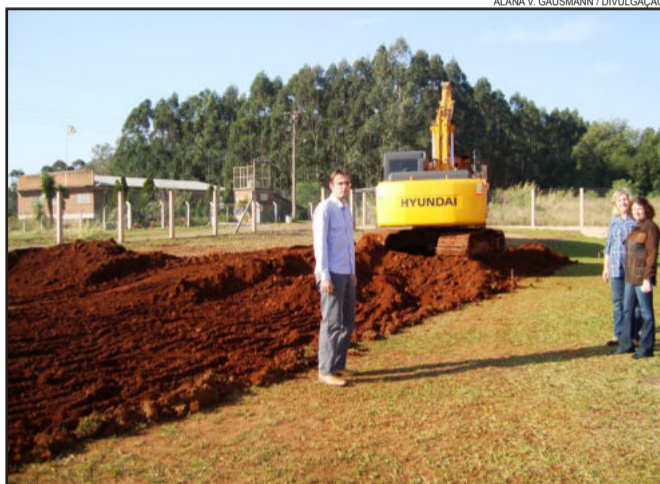
Iniciaram as obras de ampliação do CEMEF
