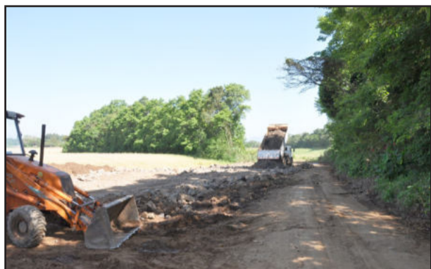
Prefeitura concluirá as obras em no máximo dez dias
