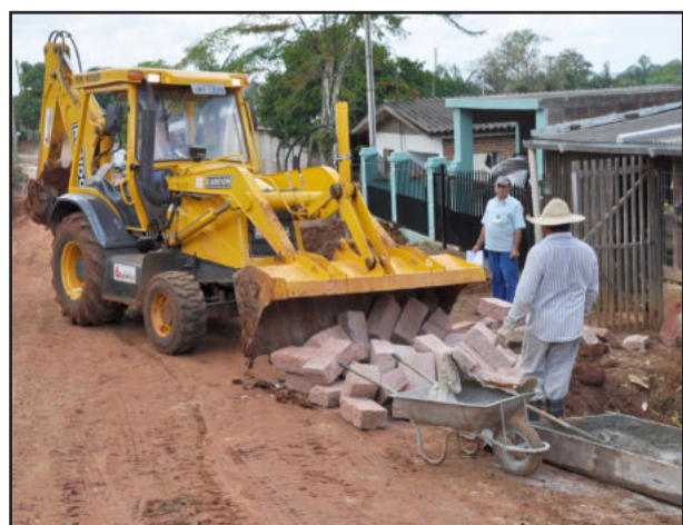
Obras de canalização estão sendo feitas antes da pavimentação asfáltica
