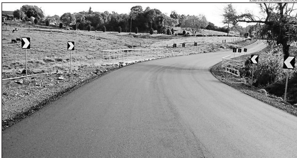
Ponte em Linha Clara já recebeu proteções quando da pavimentação em junho de 2013
