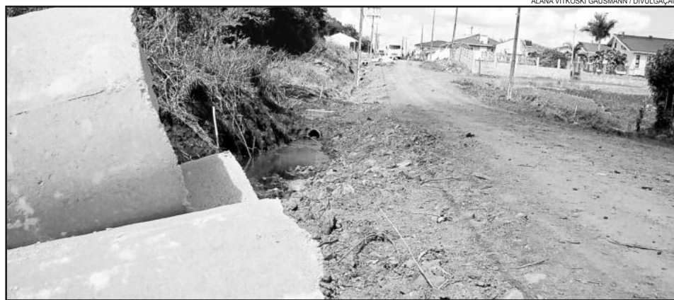
Colocação de tubulação na Rua Décio Bohmer
