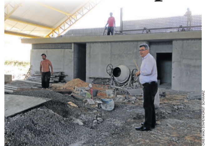
Ginásio do Complexo Escolar já está coberto
