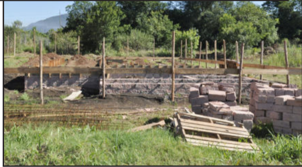
Obras do novo Posto de Saúde do Bairro Teutônia
