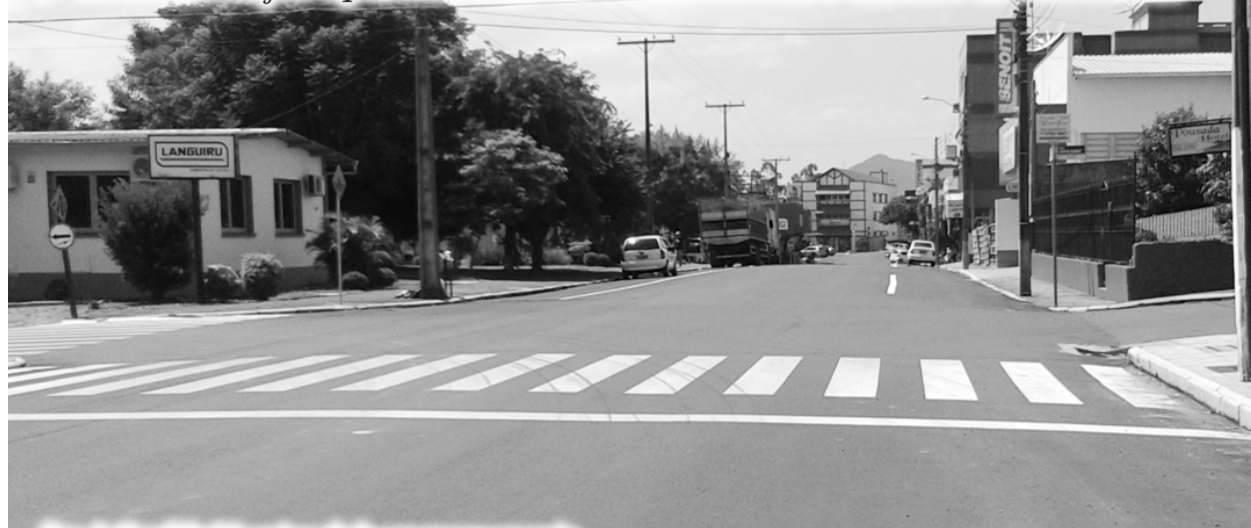
Rua Arthur Pilz foi contemplada com recapeamento asfáltico desde a Via Láctea até a Rua 3 de Outubro
