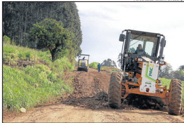
Obras foram concluídas na sexta-feira passada
