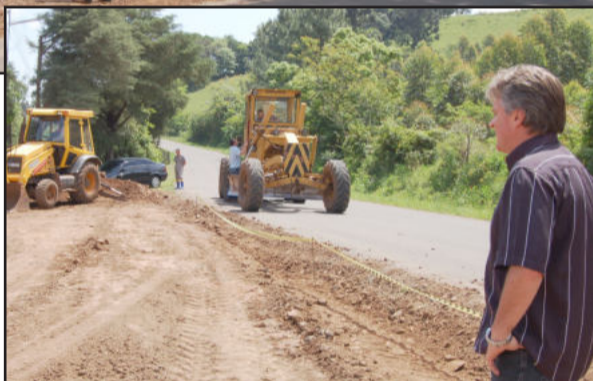
Obras de terraplenagem para pavimentar acesso e estacionamento do Avante de Boa Vista Fundos
