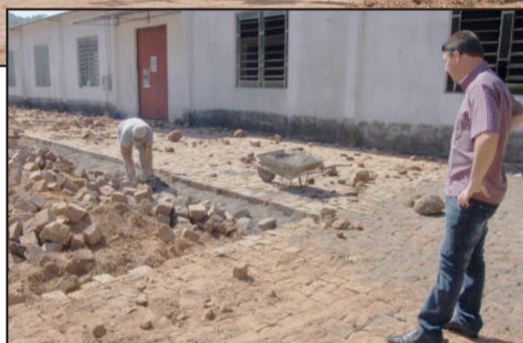
Em Boa Vista Fundos, paralelepípedo está em fase de colocação
