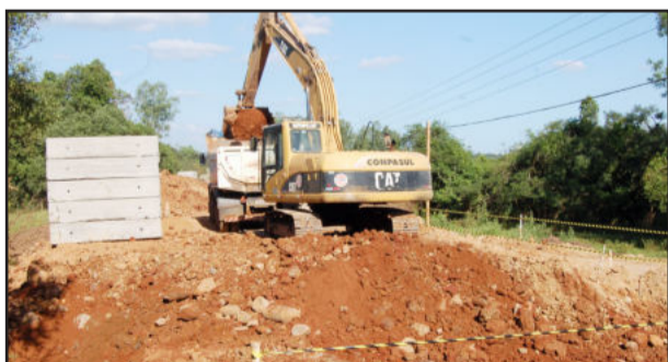
Obras de construção da galeria iniciaram após a realização da Expowink
