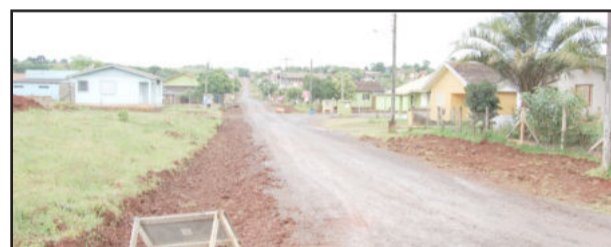
Começaram as obras de pavimentação da Rua João Musskopf, em Canabarro
