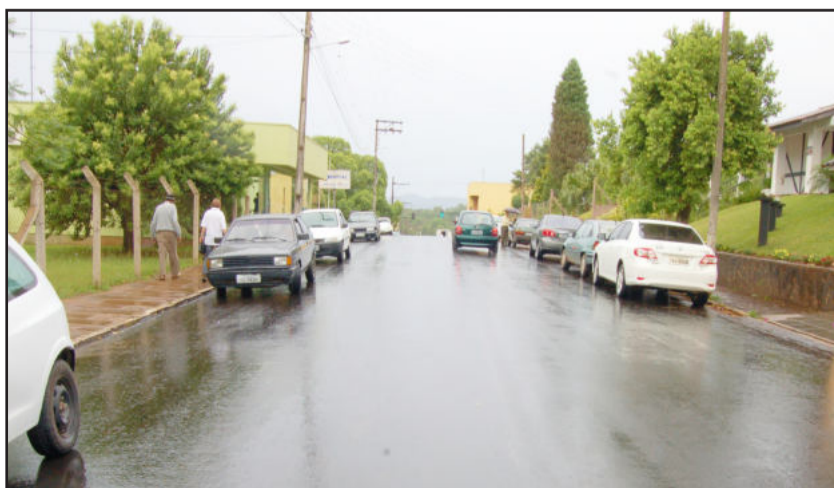
Rua Arnaldo Krug, em Canabarro, recebeu capa asfáltica diante do Centro Avançado de Saúde
