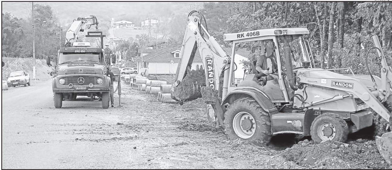
Recursos próprios para a tubulação e iluminação do acesso para Westfália
