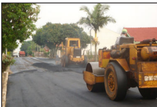
Pavimentação da Balduino Pedro Vier também foi recuperada
