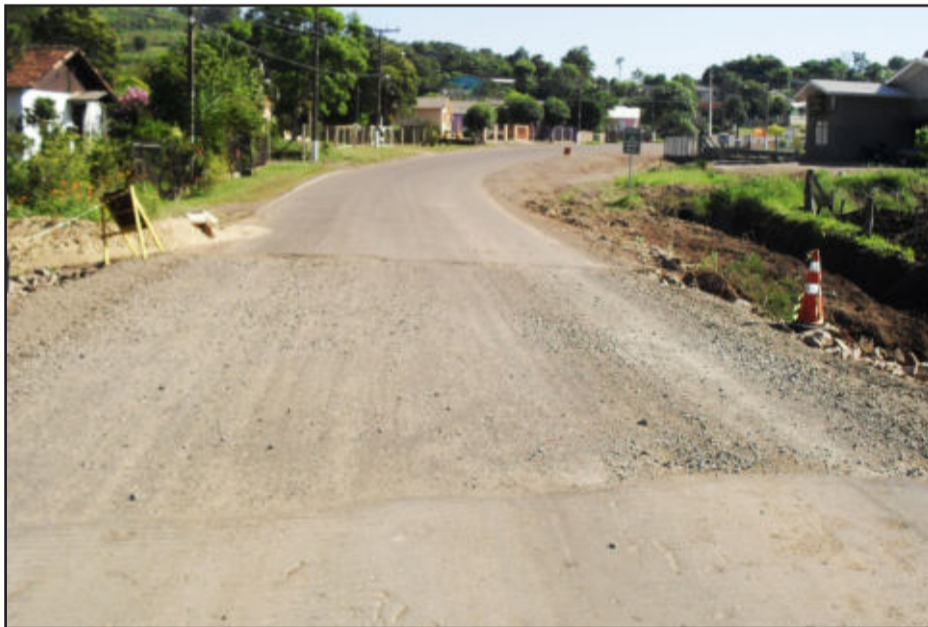
Obras visam diversas melhorias no Bairro Morro Bonito
