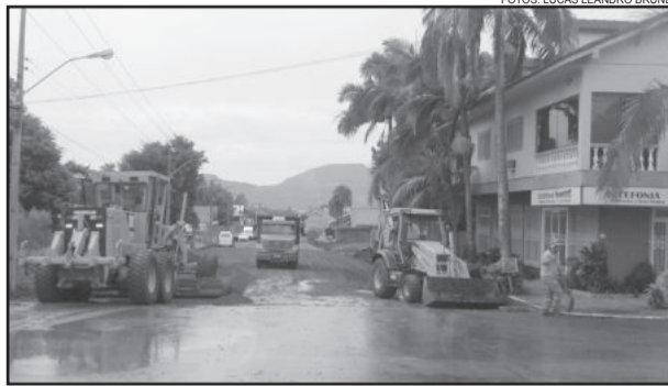
Avenida 1 Oeste recebe a base para a pavimentação
