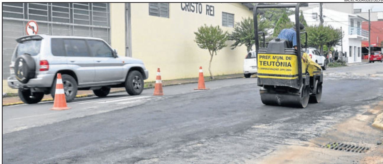
Recuperação do capeamento de trecho danificado foi concluído ontem
