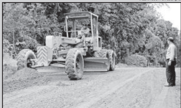
Prefeito vistoria obra na Rua Antonio Gregoletto
