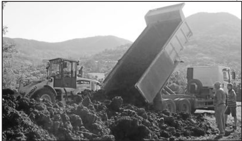
Terraplenagem foi iniciada nesta semana
