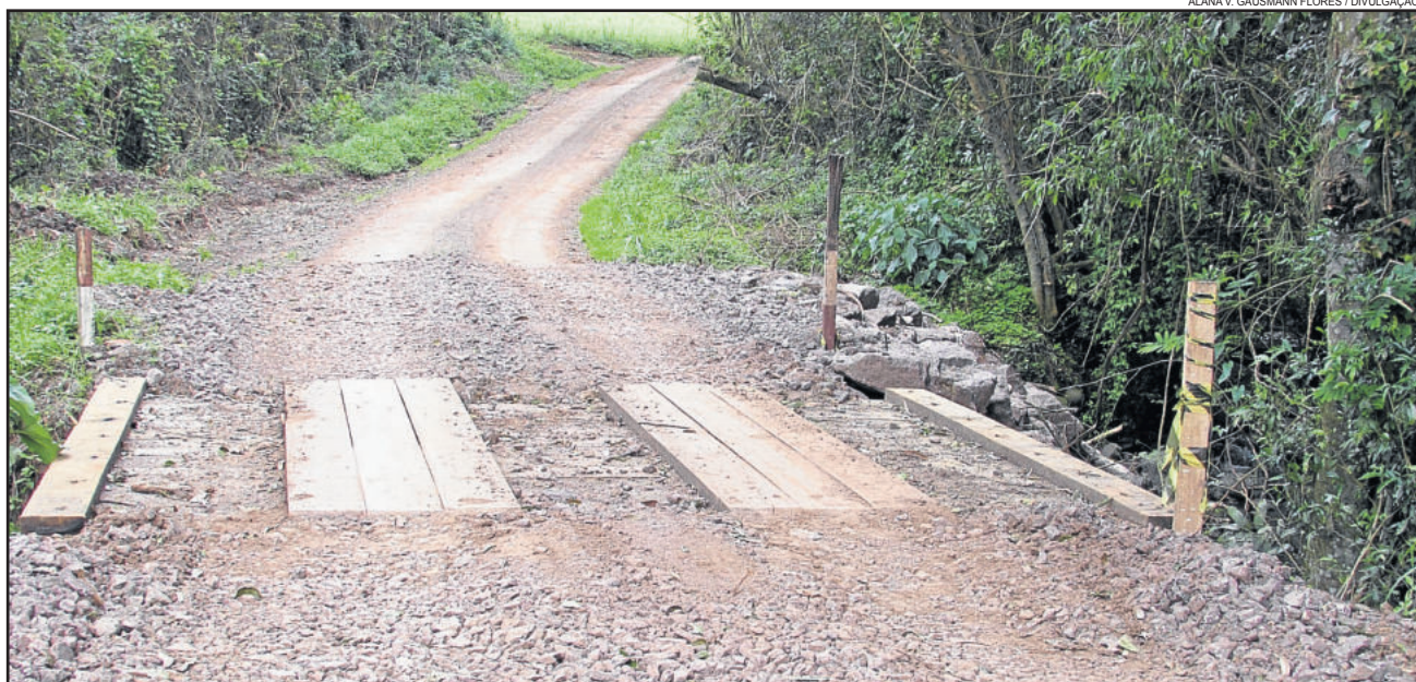
Recuperação de ponte na Linha Catarina
