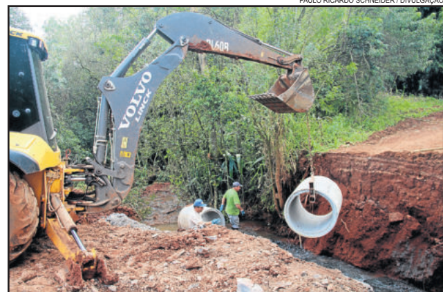
Bueiro localiza-se na Estrada Municipal Nicolau Schneider
