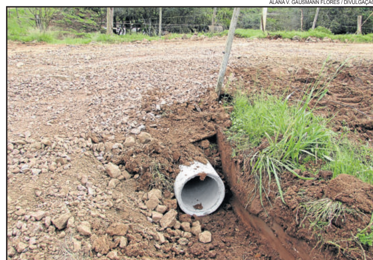
Bueiros e canalizações precisaram ser refeitos em vários locais
