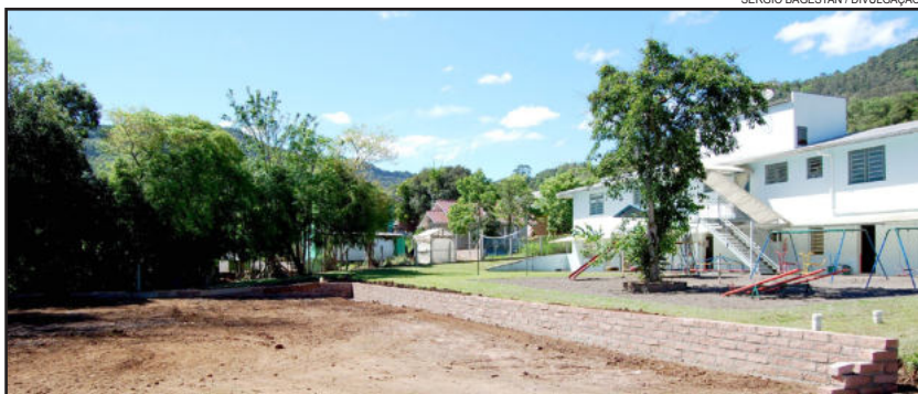
Quadra esportiva está sendo construída na Arco-Íris
