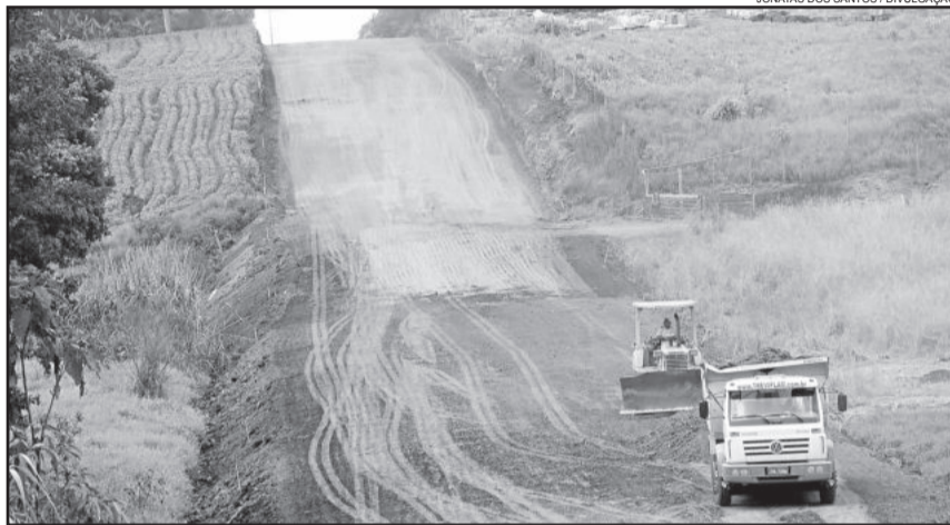
Avenida recebe obras de terraplenagem
