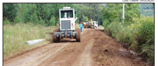
Obras têm o objetivo de melhorar a trafegabilidade
