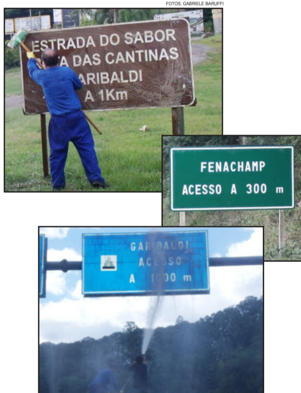
Limpeza das placas foi realizada
