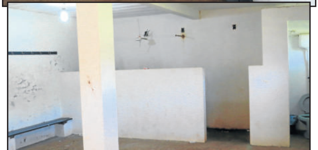
Túnel de acesso e vestiário vão ser reformados
