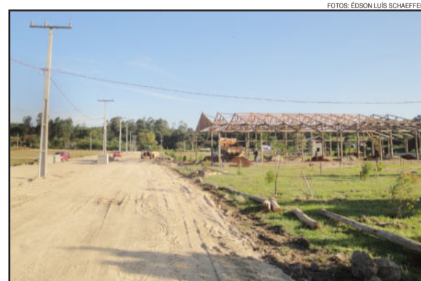
Semana foi de preparar a estrutura do parque
