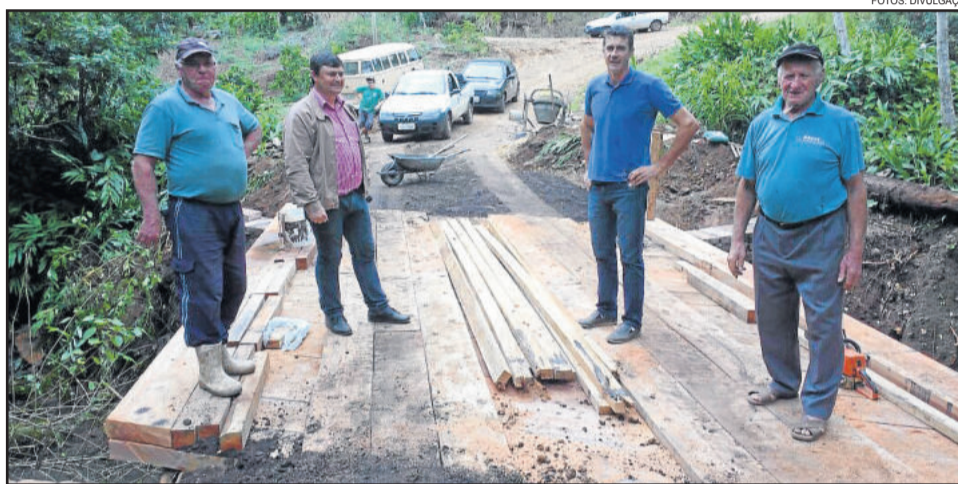
Prefeito em exercício de Boa Vista do Sul e secretário de Obras de Imigrante, conferindo a obra da ponte entre Boa Vista do Sul e Imigrante, na Vale da Harmonia
