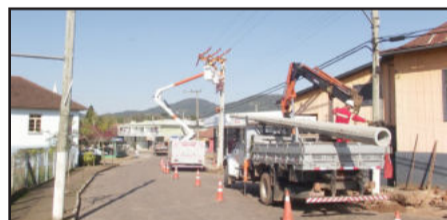
Troca de postes, cabos e limpeza de redes estão previstas pela AES Sul
