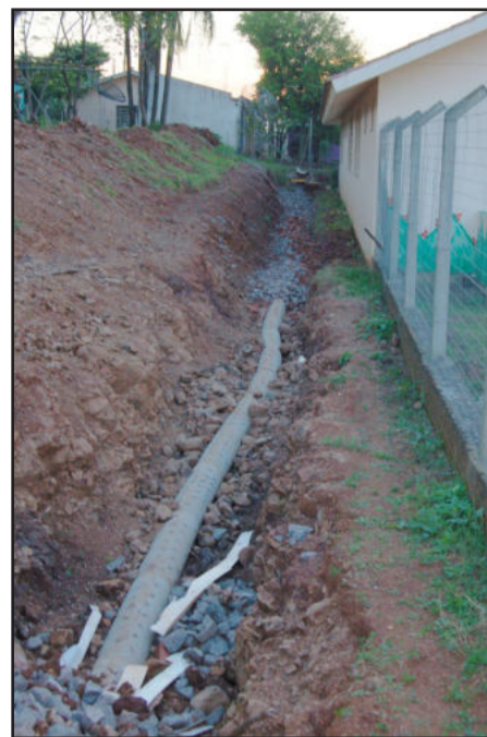
Canalização foi realizada para escoar a água nos fundos da Escola Infantil
