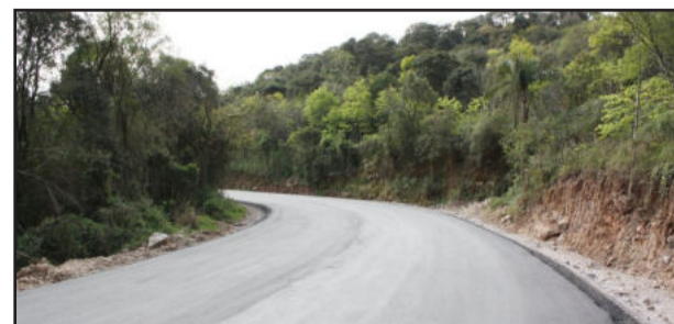
Pavimentação encurtará distâncias entre Garibaldi e Bento Gonçalves
